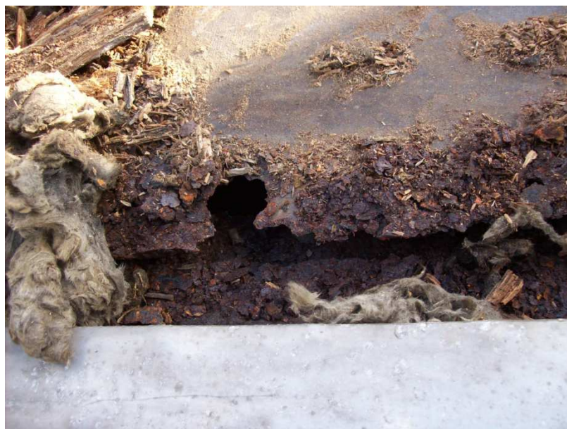
Az acéltartály külső felületének korrodálódása
