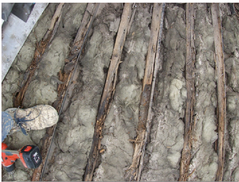
Korhadt párnafák, és előregedett hőszigetelés
